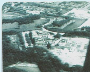
皇居内の被害状況
